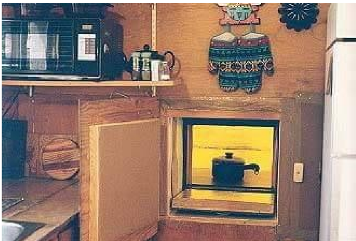
Porta del Forno Solare apribile dall'interno della casa
